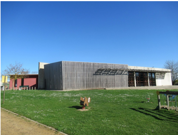
Salle du Grand Air à Breuil-le-Vert
